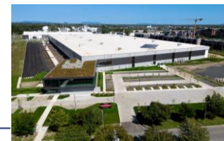
Site industriel redéveloppé
